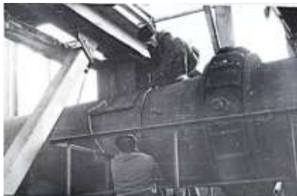
г. Астрахань. Газоперерабатывающий завод. Разрезание труб заполненных серой без остановки завода
