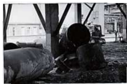
г. Астрахань. Газоперерабатывающий завод. Разрезание труб заполненных серой без остановки завода
