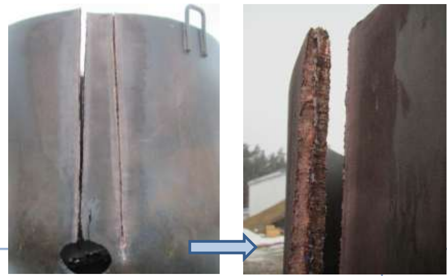
Продольная резка газопроводной трубы (К60)
