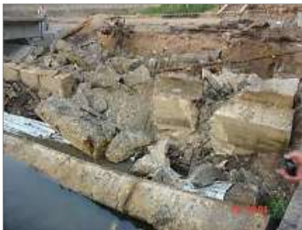
г. Саров. Разрушение опоры автомобильного моста
