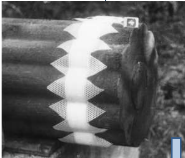
Поперечная резка стальной силовой опоры \varnothing 500
