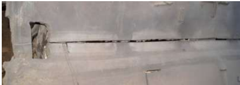
нижний рез (вид со стороны действия зарядов)
