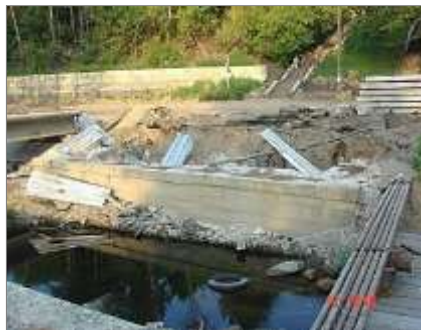
г. Саров. Разрушение опоры автомобильного моста
