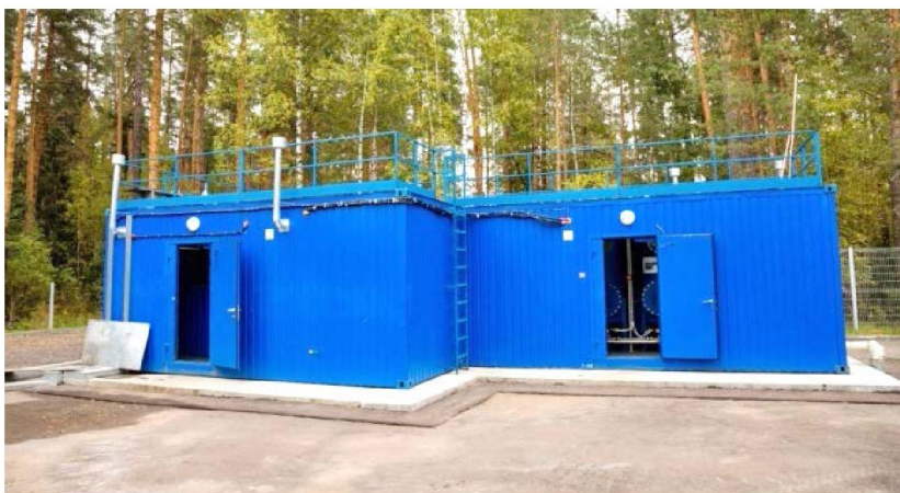
Очистные сооружения хозяйственно-бытовых сточных вод – установка КОС-30
